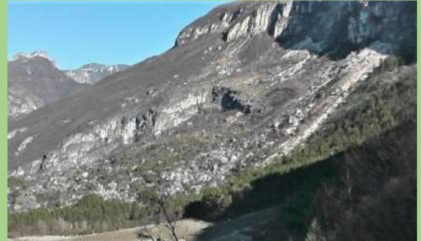
La frana del Cengio Rosso, caduta sul vecchio alveo dell'Adige ( vicino Calliano)
